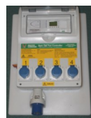
Gebläsesteuerung Barn Owl mit Temperatur- und Feuchtigkeitsmessung
