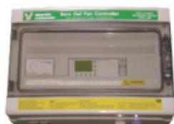
**Eigenständige Temperatur- und Feuchtigkeit-Gebläsesteuerung von Barn Owl** – umfassende Steuerung der Kühlung und Trocknung von Erntegut
